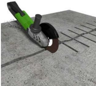
Dále uděláme několik příčných řezů kolmo přes prasklinu zhruba každých 15-20 cm. Každý řez by měl být dlouhý zhruba 12 cm, aby bylo možné do něj vložit 10 cm dlouhou sponu. Šířka řezů by měla být ideálně kolem 0,5 cm. Hloubka těchto průřezů by měla být zhruba polovina hloubky betonové desky, kterou sešíváme.
