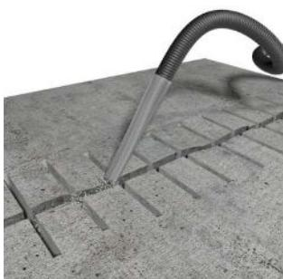
Po dokončení průřezu je nutné otvory důkladně vysát nebo vyfoukat stlačeným vzduchem, aby se odstranili veškeré nečistoty a prachové částice. Dále je důležité plochu očistit od případných mastných znečištění.
